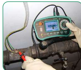
Sprawdzanie połączeń wyrównawczych
